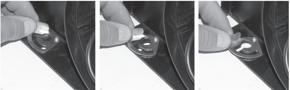
Zeichnen Sie die Lage der Bohrung „B“ an der Wand an. Anschließend nehmen Sie die Dunstabzugshaube wieder von der Wand, erstellen die Bohrung „B“ und setzen je einen Dübel 8 mm (13) ein.
